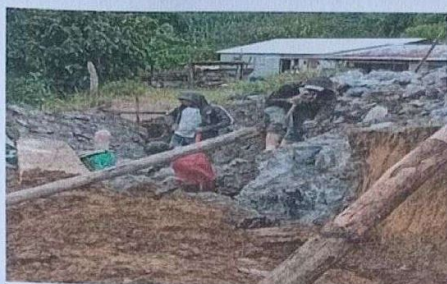
Foto 1: MEJORAMIENTO DE MURO PERIMETRAL
