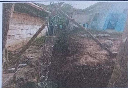
Foto 5: MEJORAMIENTO DE MURO PERIMETRAL
