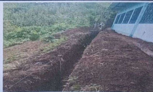
Foto 6: MEJORAMIENTO DE MURO PERIMETRAL
