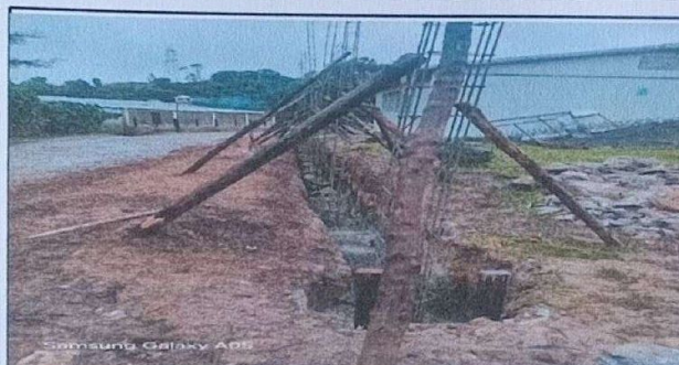
Foto 3: MEJORAMIENTO DE MURO PERIMETRAL
